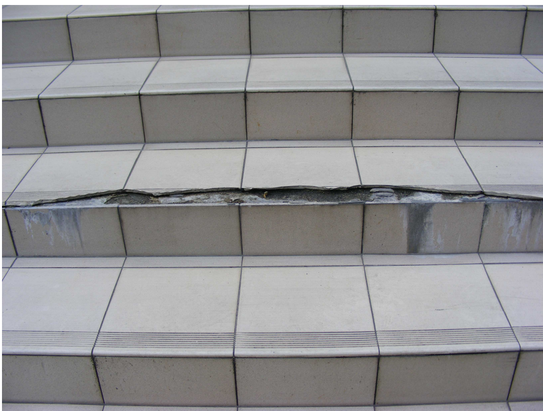
Okładziny stopni schodów
