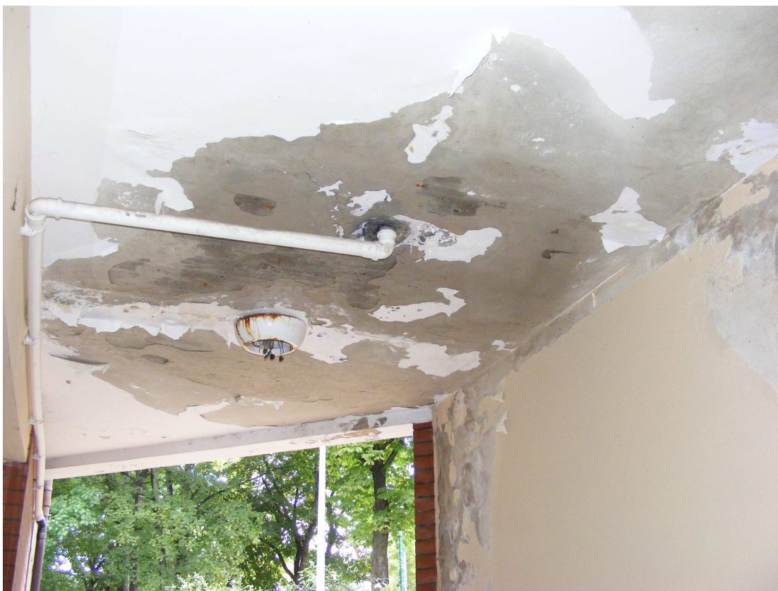
Sufit i ściany pod spocznikiem
