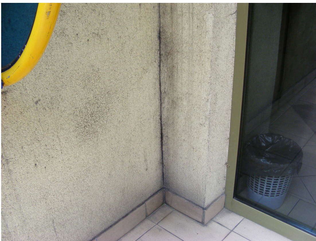
Dylatacja ocieplenia ścian
