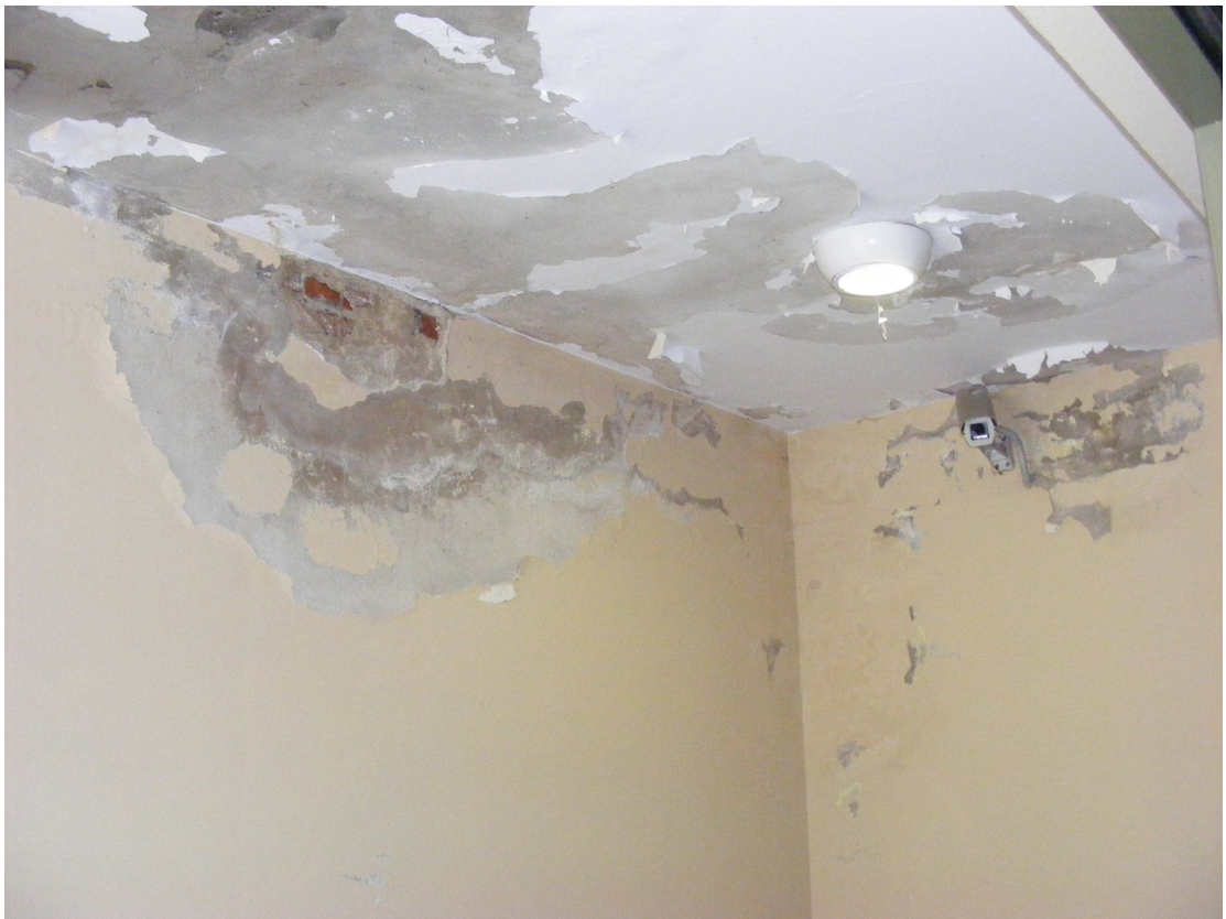
Sufit i ściany pod spocznikiem
